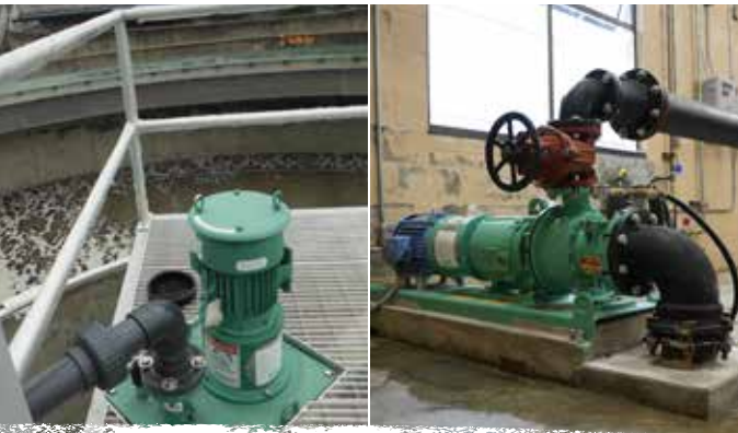
Espuma de clarificador primaria
