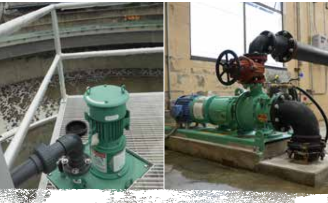
Espuma de Clarificador Primaria
